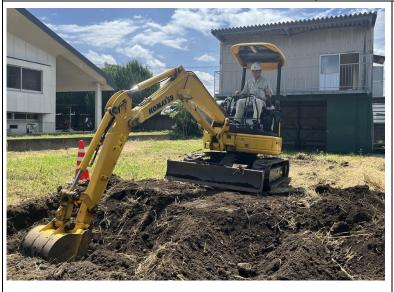
この写真は**、バックホウで掘削** (穴を掘る) 作業を行っています。
